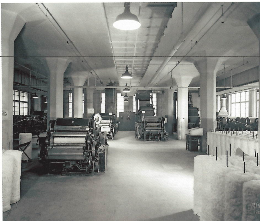
Karderie im Putzereigebäude aus den 1920er Jahren
