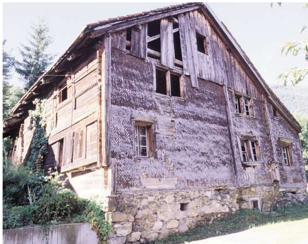
Verwahrloster Zustand: Das Strickhaus am Hang oberhalb von Wangs wurde 2010 abgebrochen.
