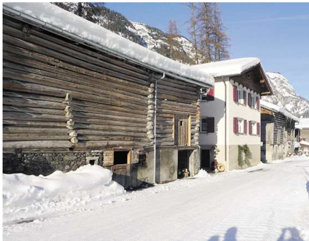
Denkmalpflege war gegen den Abbruch: Stallgebäude an der Langgasse in Vättis.
